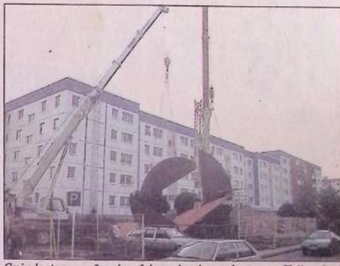
Guindaste em ação: obra foi a primeira a chegar em Hellersdorf
